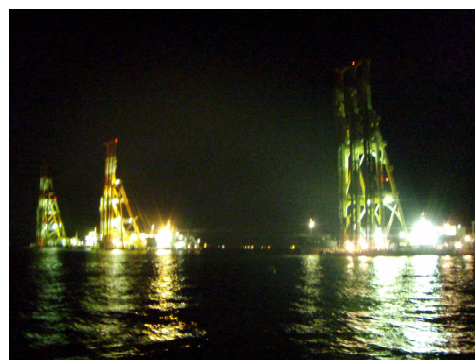
写真-3 SCP 打設状況
