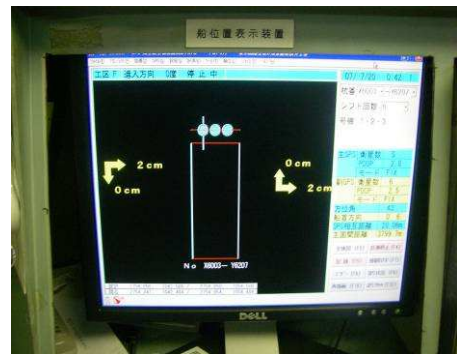
写真-5 砂杭の位置管理システムのモニター
