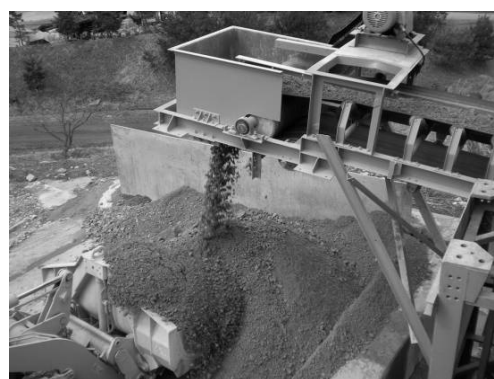
写真-11 排出状況
