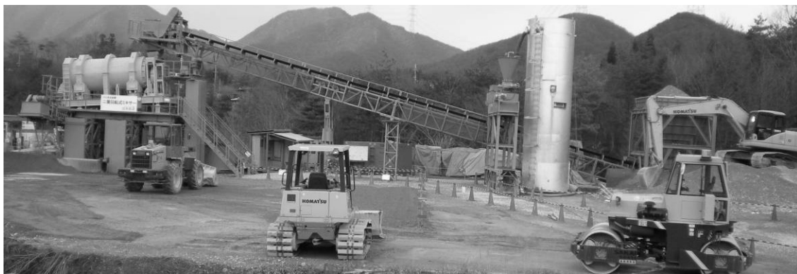
写真-6 CSG 混合プラント全景
