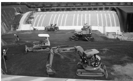
写真-4 トンネル坑口部改良工
