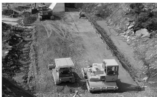
写真-3 上流締切施工状況
