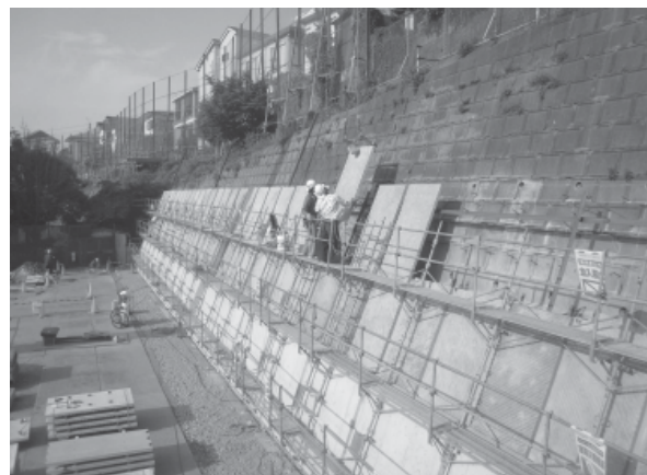
写真-8 パネル設置時（足場は基部のみ）
