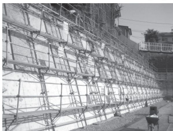
写真-10 簡易足場とプレキャスト擁壁設置状況
