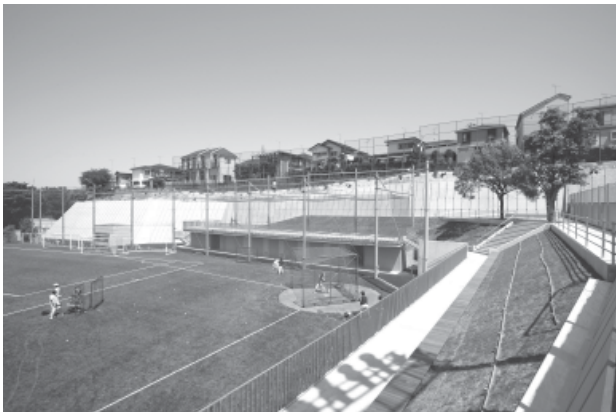
写真 -13 倉庫棟と通路、擁壁を望む
