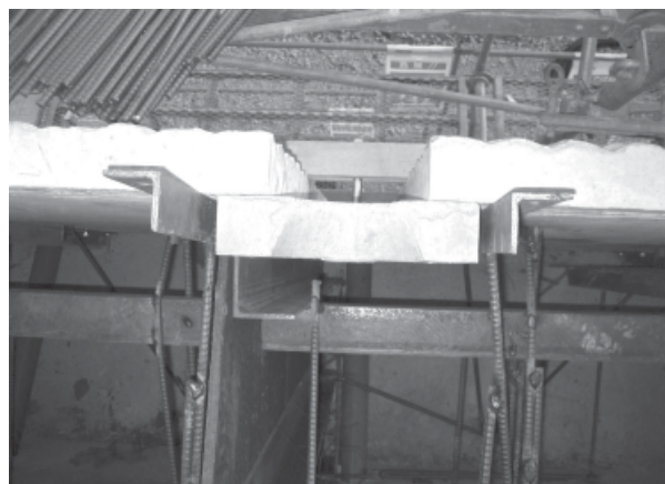
写真-9 プレキャスト型枠と第3の壁の設置状況
