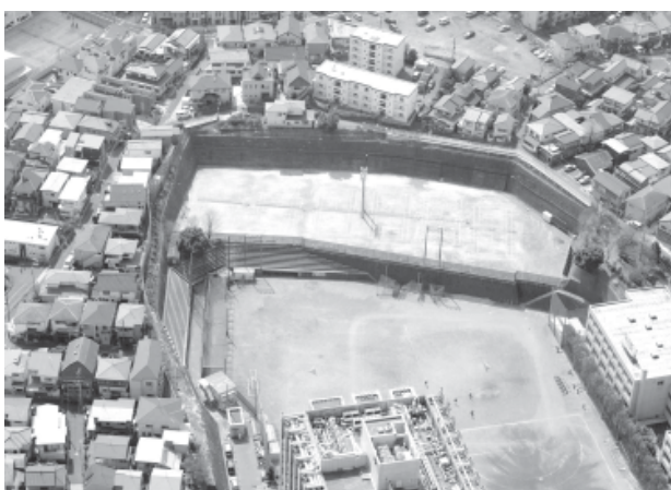
写真-1 既存擁壁構造物と周辺環境
