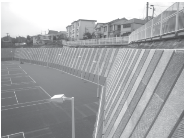
写真 -12 公園から眺めた擁壁と住宅地
