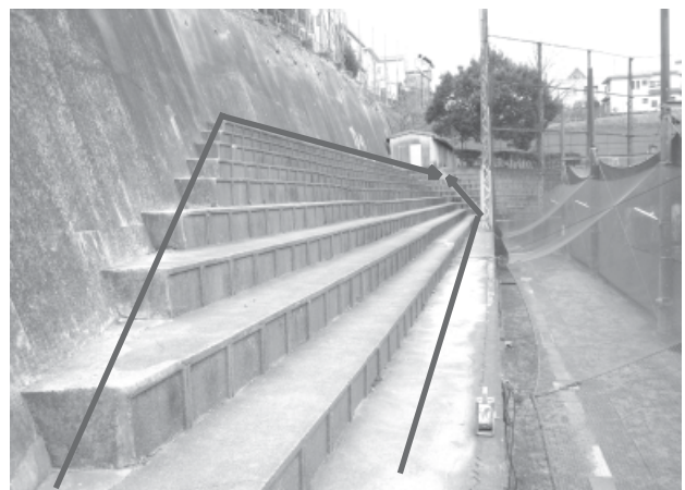
写真-2 擁壁沿いに歩くテニスコートへの動線
