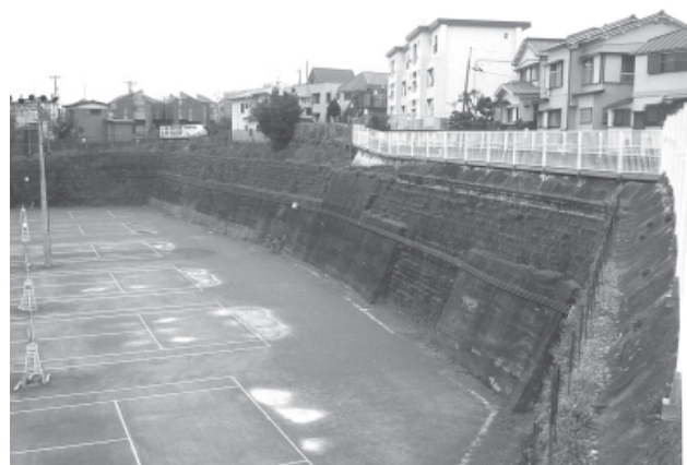
写真-3 擁壁構造物とテニスコート
