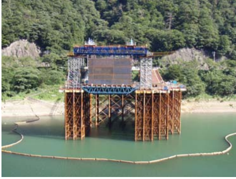
写真-2 鋼殻組立て
