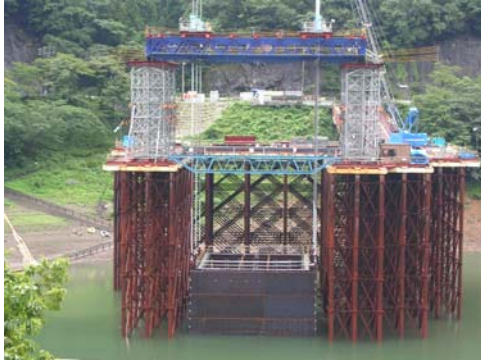
写真-3 鋼殻ケーソン吊降し
