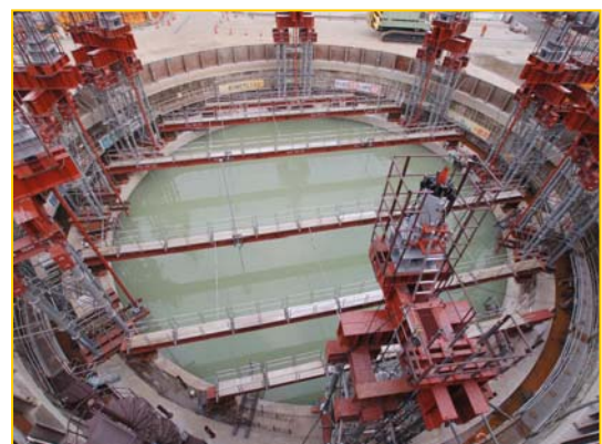
写真-6 鋼殻桁吊降し完了
