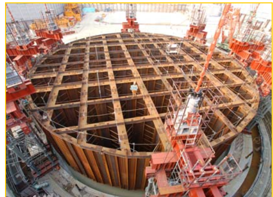
写真-4 鋼殻桁組立完了（吊降し開始）
