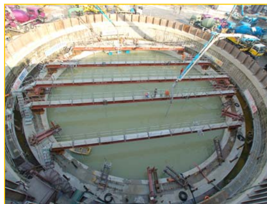
写真-7 鋼殻桁内部水中コン打設状況
