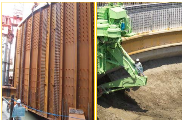
写真-1 ジベル設置状況
