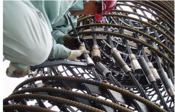
写真-5 専用治具による接続作業
