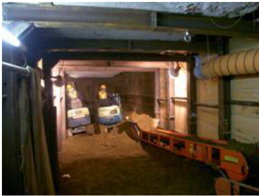
写真-1 小断面導坑掘削状況
