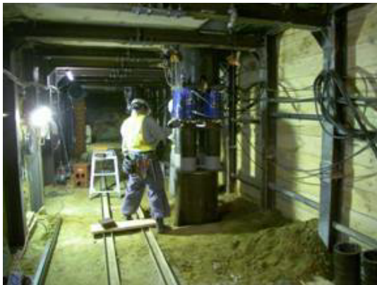
写真-2 鋼管杭圧入状況
