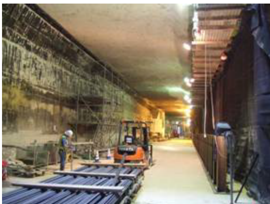
写真-4 掘削完了後の状況
