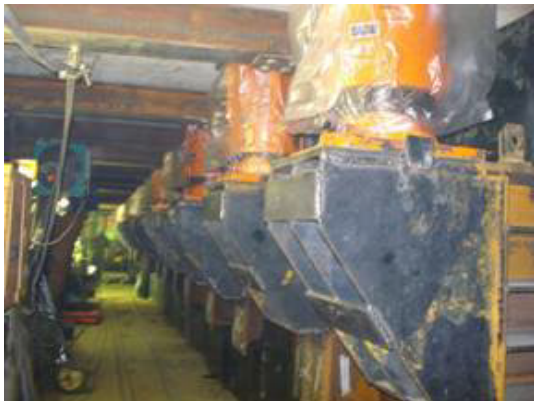
写真-3 ブラケット設置・油圧ジャッキ载荷状況
