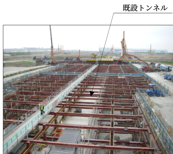
写真-1 掘削時全景
