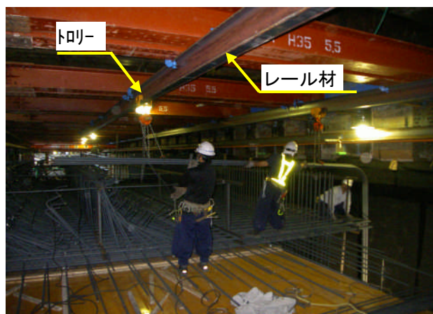
写真-7 鉄筋組立状況（頂版組立）
