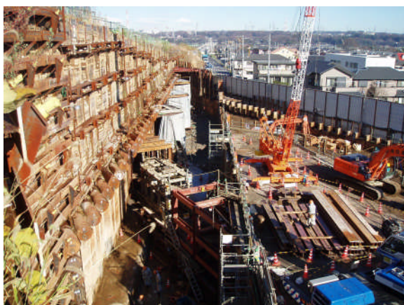
写真-4 簡易シールド工施工状況(起点側)
