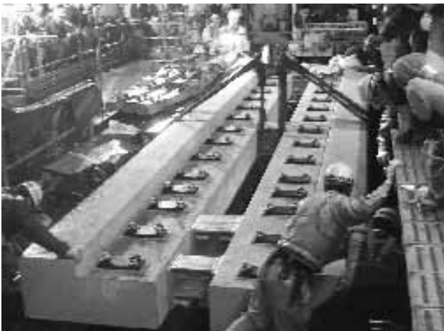
写真-6 架設状況
