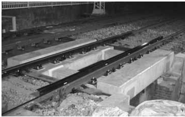
写真-11 施工完了
