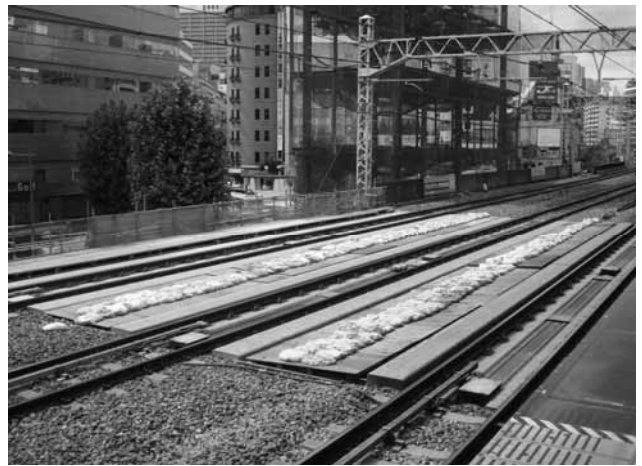
写真-7 施工完了
