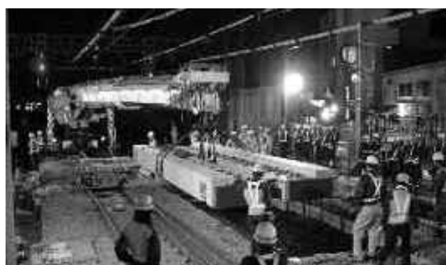
写真-5 架設状況
