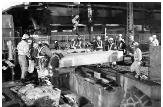
写真-10 架設状況
