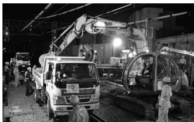
写真-4 バラスト掘削・積み込み状況
