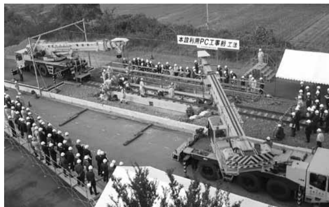
写真-2 施工状況
