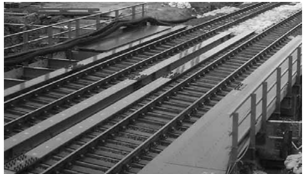
写真-1 従来工事桁（鋼製桁）
