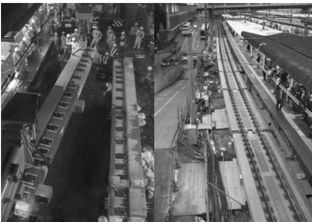
写真-8 架設状況（左）・施工完了（右）
