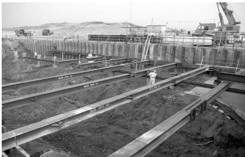
図-10 切梁設置状況
