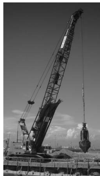
図-11 鋼管内部補強施工状況
