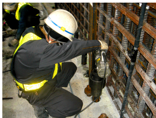
写真-5 NAPP解放状況
