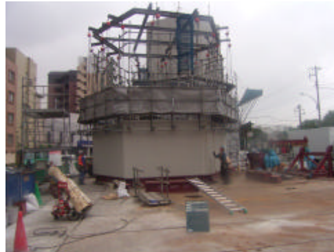
写真-3 ハンガー足場
