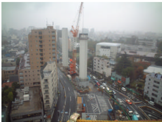
写真-4 中換気塔構築状況
