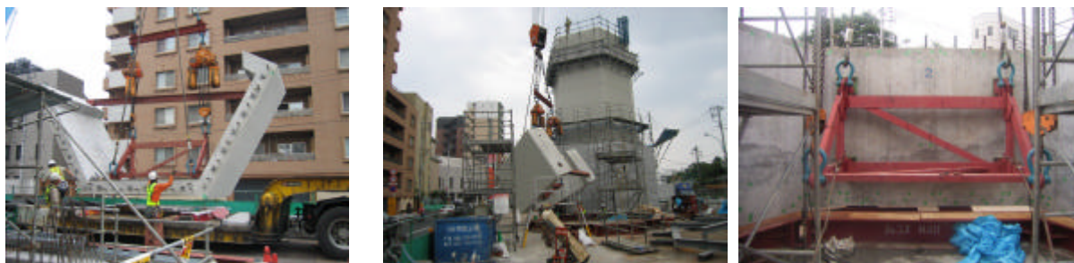
写真-2 プレキャスト部材の荷下し～建起し
