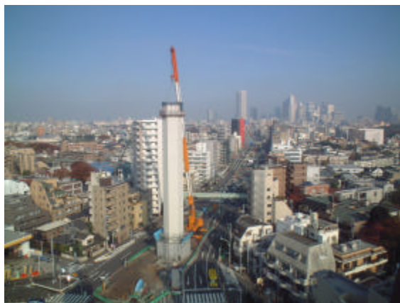
写真-5 北換気塔構築状況
