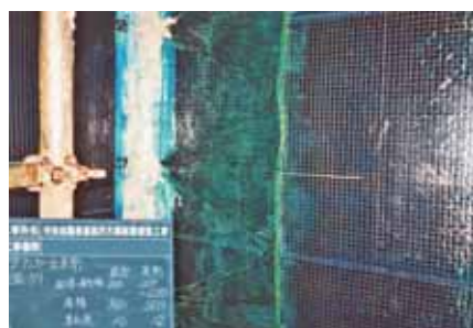
写真-10 CFアンカー設置工完了
