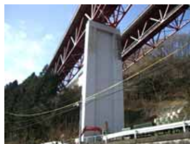
写真-11 施工後全景
