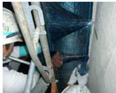
写真-9 CFアンカー設置工
