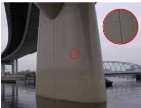
図-4 補強後の RC 橋脚
