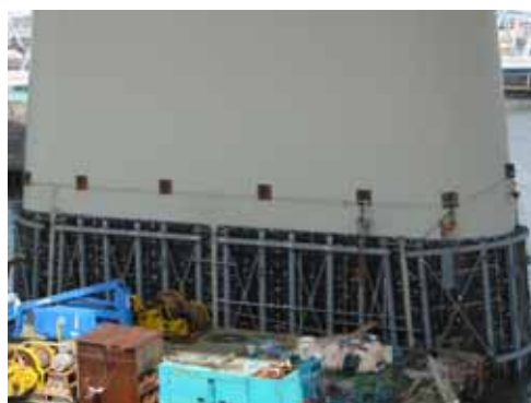
写真-5 閉合完了後状況
