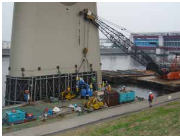
写真-6 施工状況
