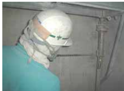
写真-8 CFアンカー埋込部削孔工
