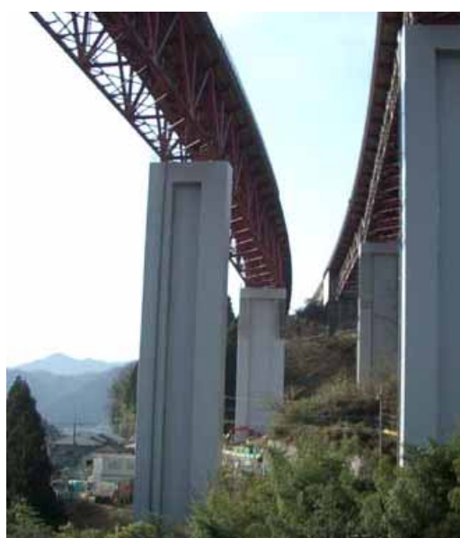
写真-7 トラス橋全景
