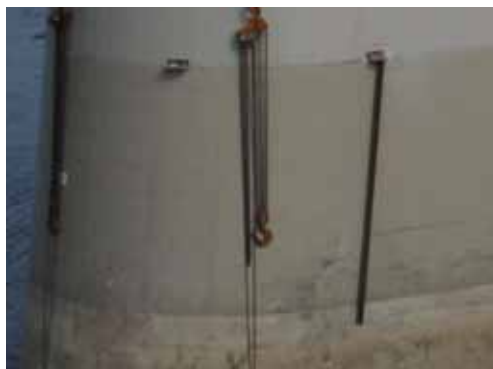
写真-3 据付用ガイド（左：鋼板設置前，右：鋼板設置後）
