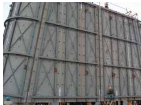
写真-2 補強材取付状況 (工場仮組)
