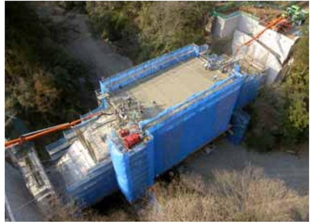
写真-4 アーチリブコンクリート打設状況
