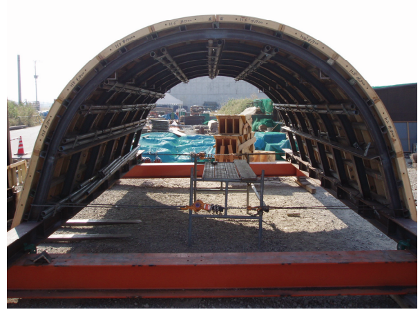
写真-5 主塔結合部アーチ型枠
