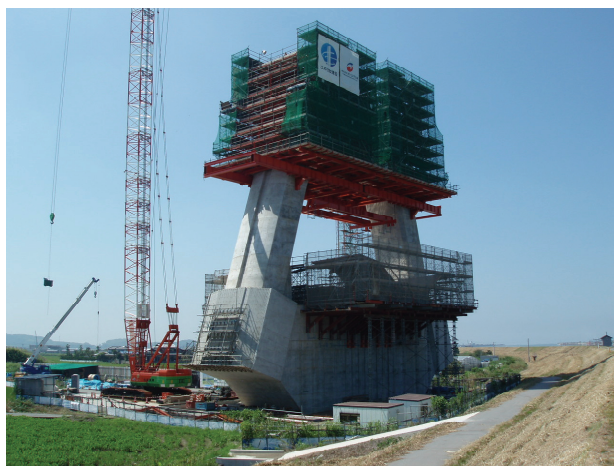
写真-1 施工状況
