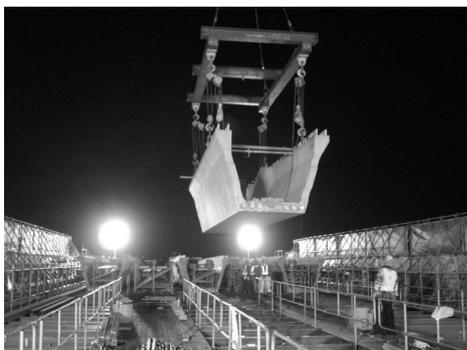
写真-7 UFC 桁の夜間架設
