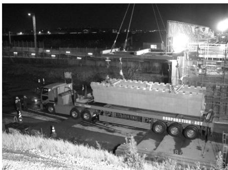
写真-6 UFC 桁の運搬・搬入
