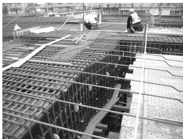
写真-2 SRC部鉄筋・型枠組立状況
