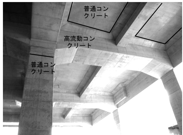
写真-6 SRC部施工後外観
