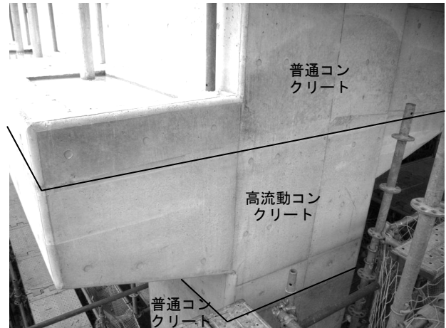
写真-11 高密度配筋部施工後の外観
