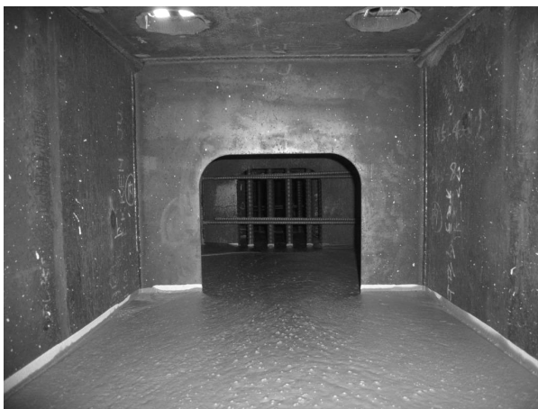
写真-3, 4 高流動コンクリート打設状況
