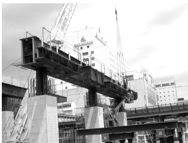
写真-1 R12 鉄骨架設状況
