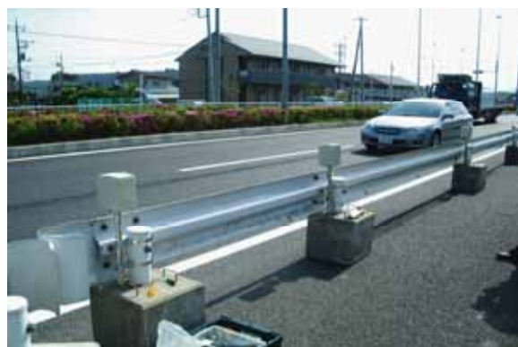
写真-1 ガードレール設置事例
