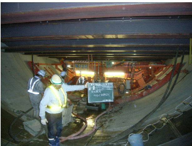
写真-3 型枠セット状況
