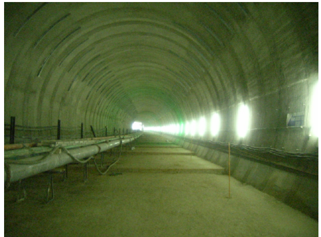
写真-5 流動化処理土打設完了
