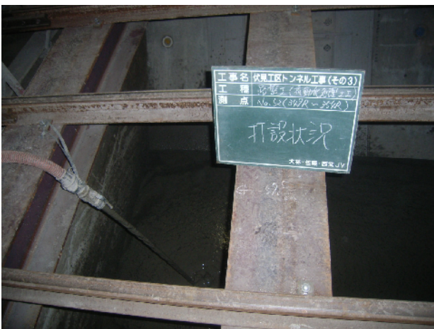
写真-4 流動化処理土打設状況
