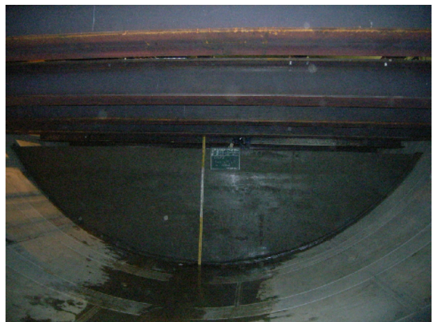
写真-6 流動化処理土打設断面
