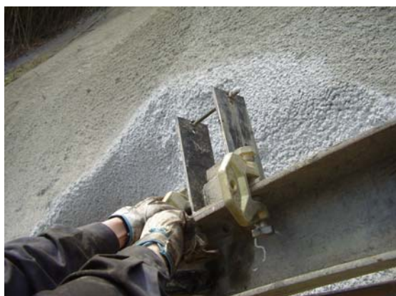
図-5 鋼管受け設置状況
