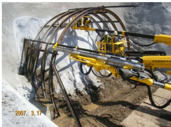
図-4 鋼管打設状況
