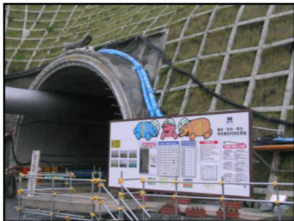
写真-5 坑口安全対策状況
