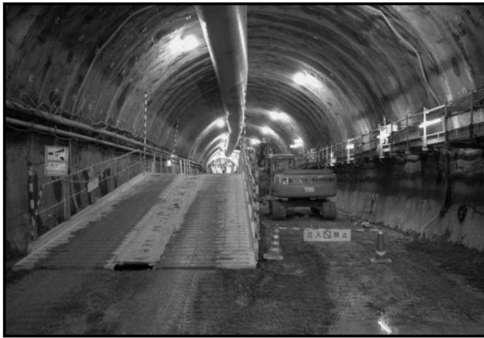
写真-3 上半乗上げ棧橋とブラケット安全通路
