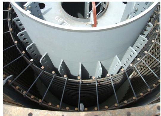
写真-3 橋脚第1節設置
