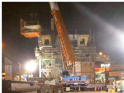
写真-7 鋼床版張出し部の夜間架設
