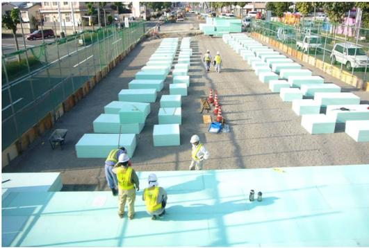
写真-14 EPS軽量盛土の施工(1)
