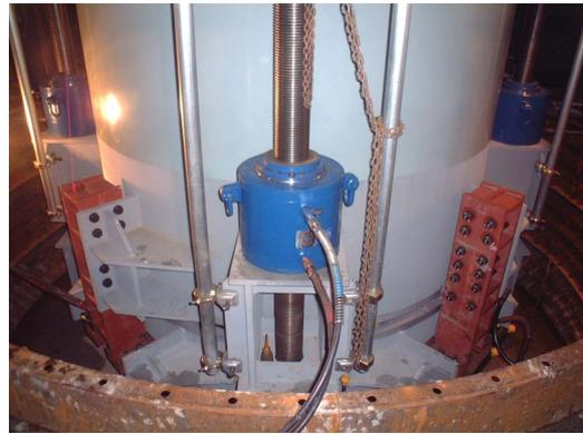
写真-11 橋脚基部の連結部
