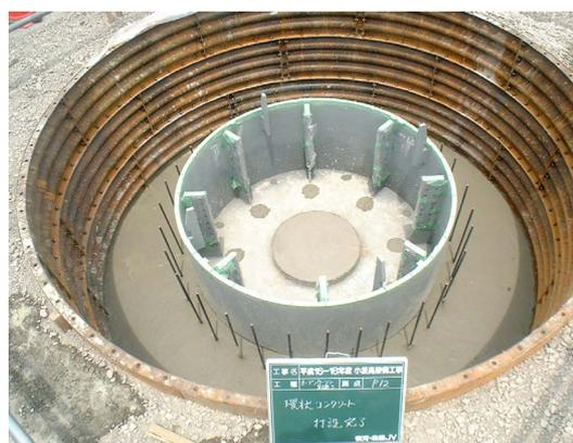
写真-4 環状コンクリート打込み完了
