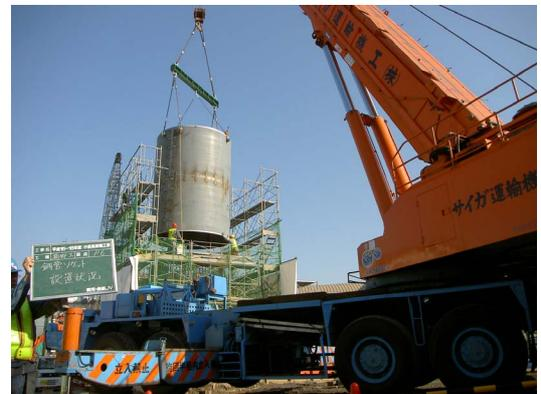
写真-2 ソケット鋼管の設置
