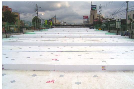
写真-15 EPS軽量盛土の施工(2)
