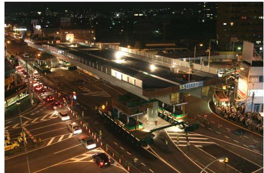
写真-9 ドーリーによる一括移動架設
