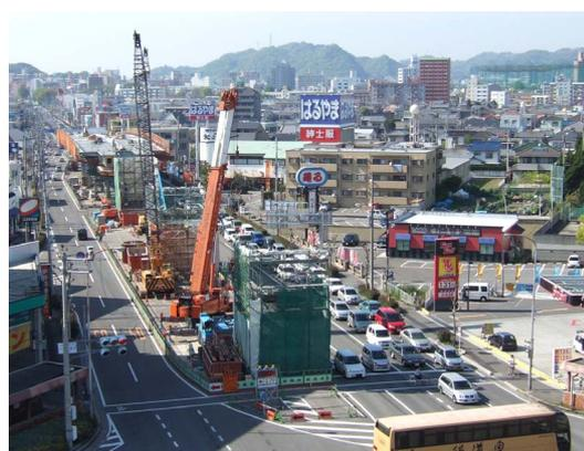
写真-5 狭隘なヤード内での上部工と基礎の同時施工
