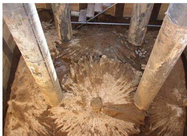
写真-2 補強体掘削状況 (実大実験) 2)
