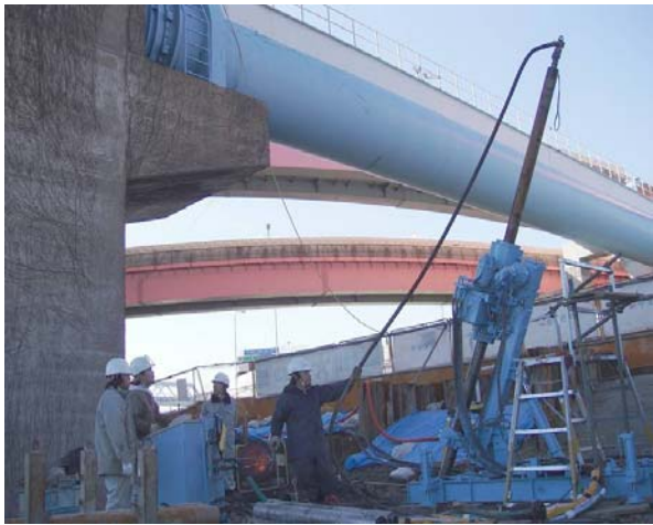
写真-3 施工状況（MJS工法）
