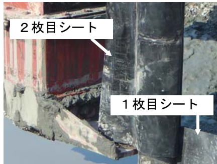
手順3：継手施工
