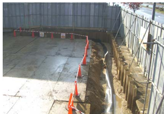
写真-6 施工完了状況
