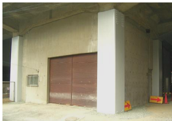
写真-6 施工完了
