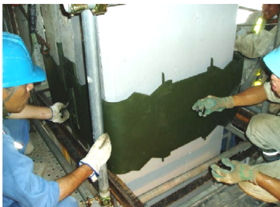
写真-4 標準部波形分割鋼板組立て状況 (1段当たり平均 20 分)
