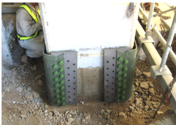
写真-3 基部波形分割鋼板組立て状況 (1段当たり平均 40 分)
