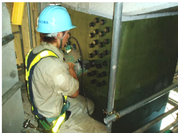
写真-5 頂部波形分割鋼板組立て状況 (1段当たり平均 30 分)
