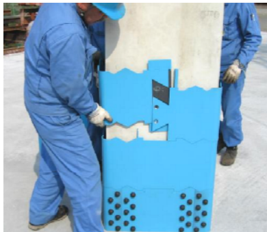
写真-1 波形分割鋼板の組立て状況
