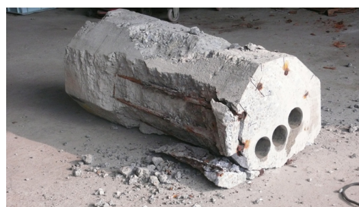
写真-2 切り出し部材の例 (P2橋脚)
