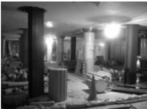
写真-2 仮設盛替状況(既設躯体解体)
