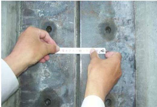
写真-2 円周方向の接合鋼板
