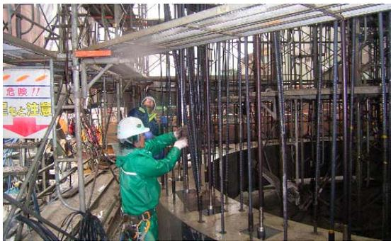
写真-6 鉄筋、PC鋼棒の組立
