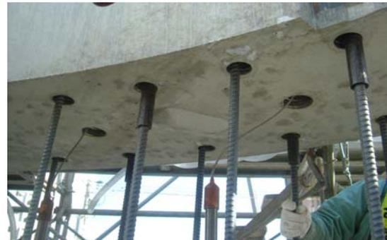
写真-8 鉄筋およびPC鋼棒の挿入
