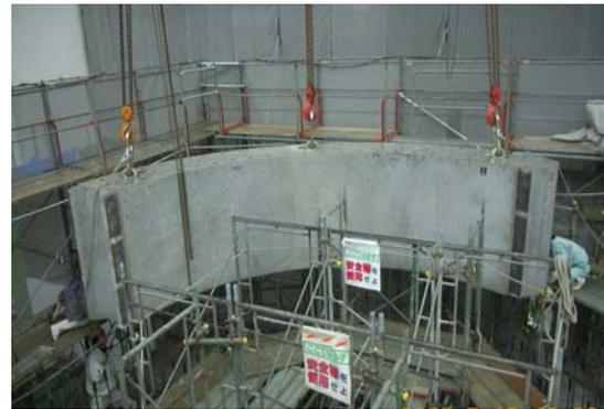
写真-7 プレキャストブロックの吊り込み
