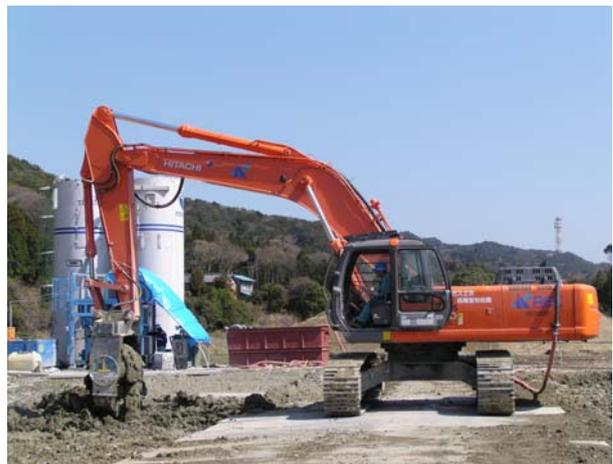
写真-3 底泥土の初期固化（トレンチャー式攪拌混合機）
