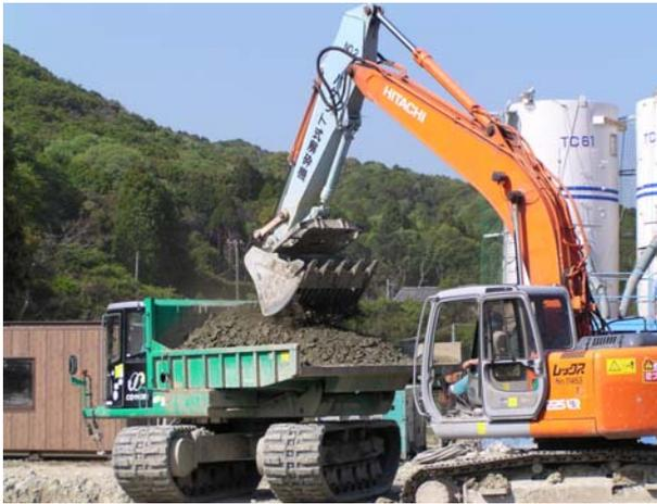
写真-5 初期固化土の解砕・積込み (バケット式解砕機)
