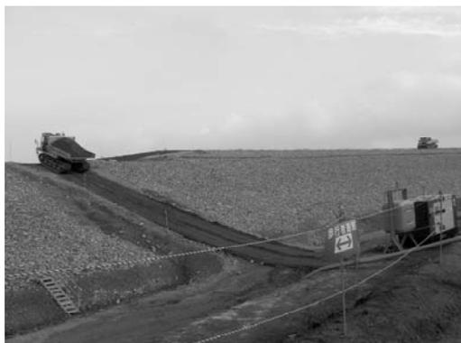
写真-4 クローラダンプによる盛立材運搬状況
