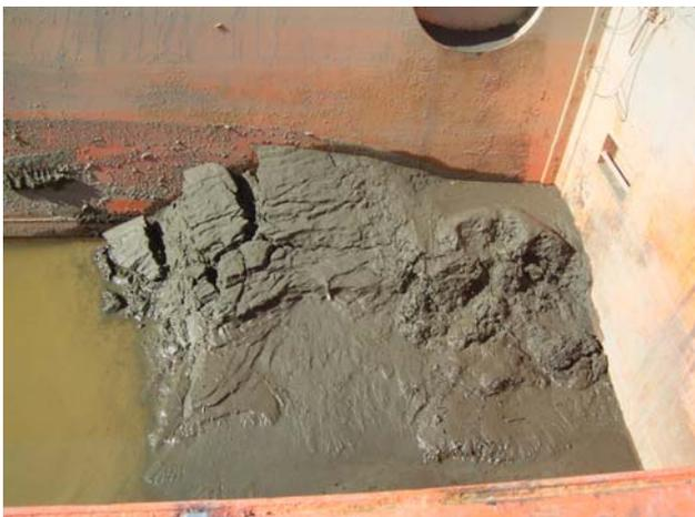
写真-8 タンク内の排出土砂：高滝ダム
