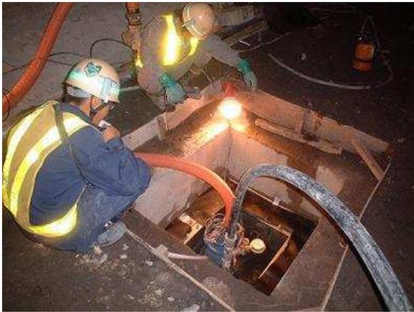
写真-2 中央仮排水管閉塞状況
