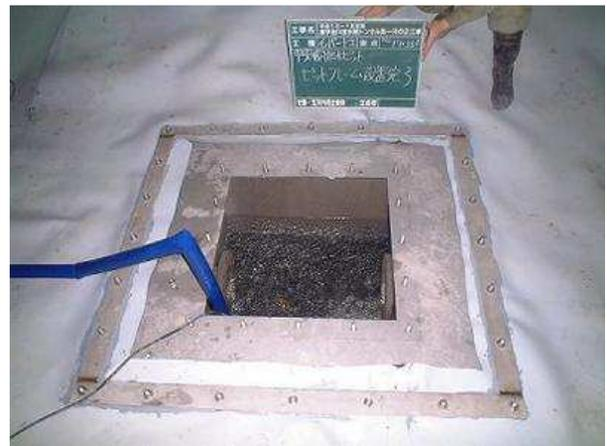
写真-3 ピットフレーム設置状況
