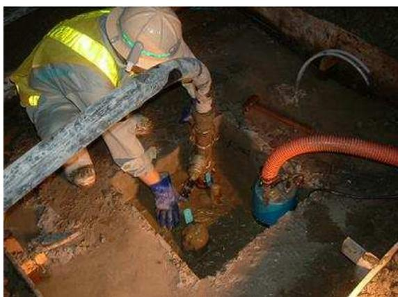
写真-5 中央仮排水ピット閉塞注入状況
