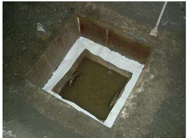
写真-1 ピット箇所防水シート開口部
