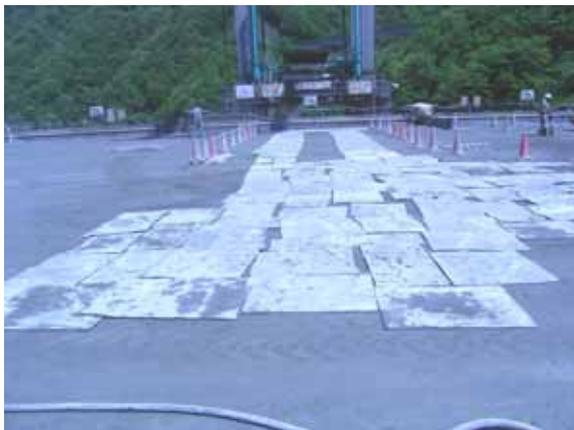
写真-4 重ダンプトラック走路養生状況
