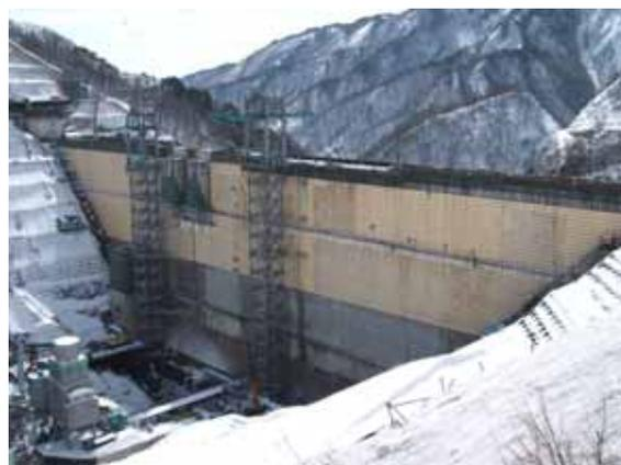
写真-1 断熱マット設置状況
