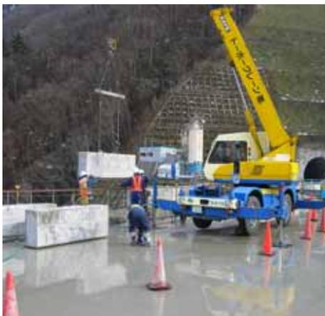
写真-2 プレキャスト部材設置状況
