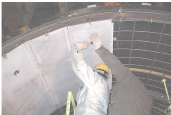
写真-1 覆工板の取付け状況
