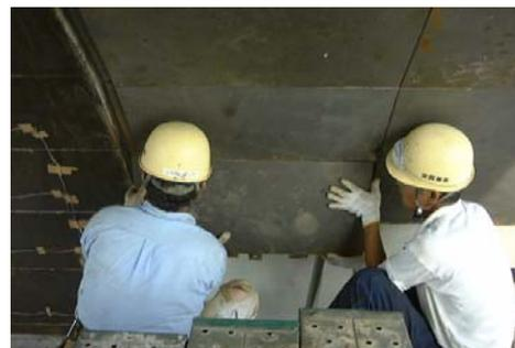
写真-7 覆工板取付状況
