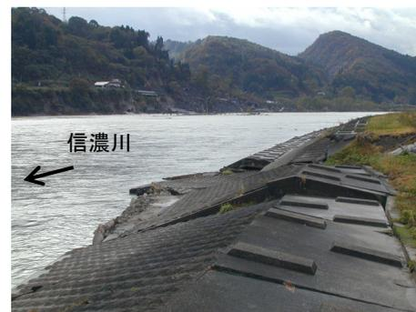
図-8 越の大橋付近の低水敷護岸の変状
