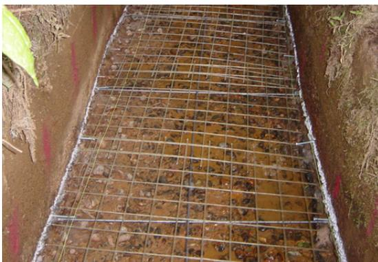
写真-2 アンカーボルトおよび有機繊維メッシュ設置状況（現場打ち込み水路底版）
