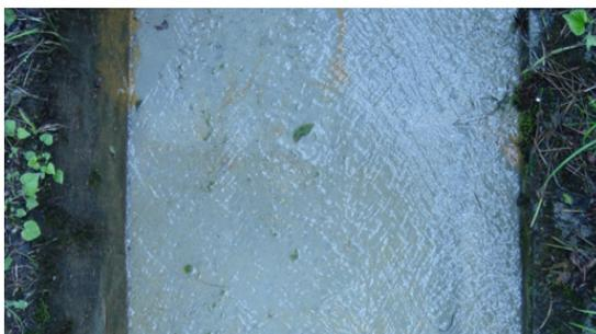
写真-7 排水路底版部の補修完了
