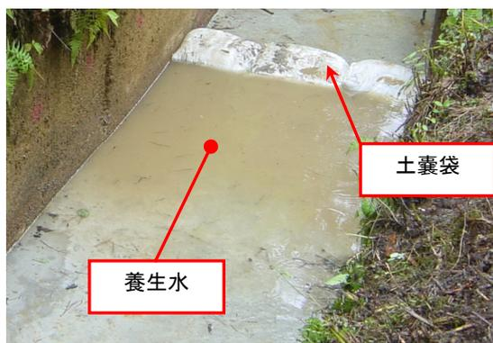
写真-6 排水（酸性水）による水中養生状況
