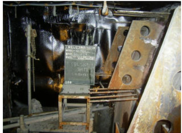
写真-4 接続プレート取付け完了状況
