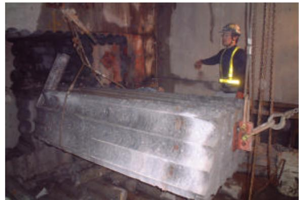
写真-2 RC地中連続壁撤去状況
