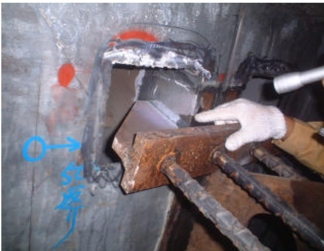
写真-3 曲げモーメント鉄筋プレート取付け状況
