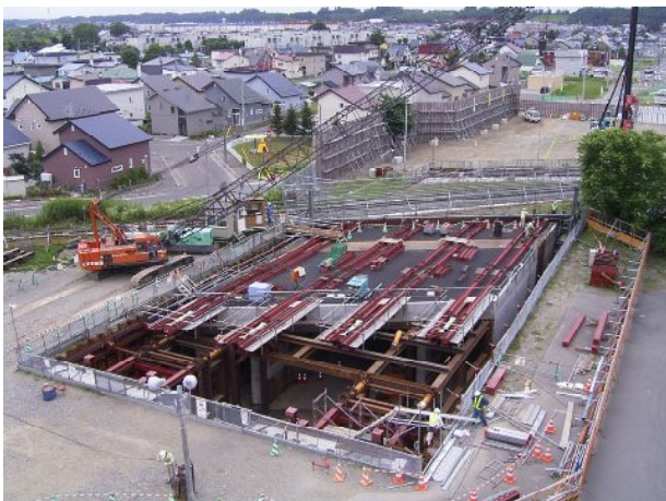
写真-7 函体推進状況
