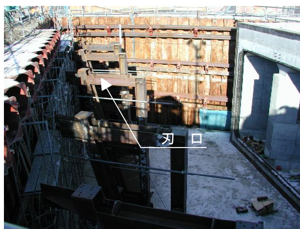
写真-4 刃口組立状況
