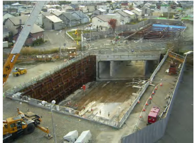
写真-9 推進完了状況
