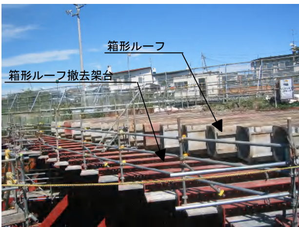
写真-8 箱形ルーフ撤去状況
