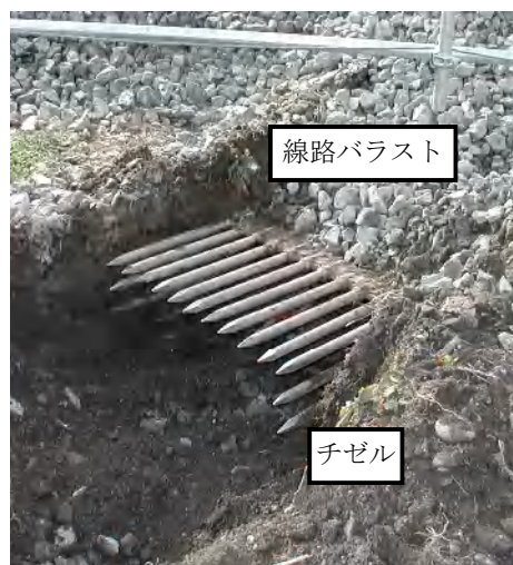
写真-12 刃口到達状況
