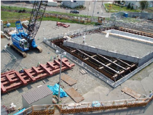
写真-6 推進設備設置状況
