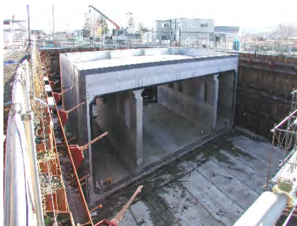
写真-3 第2函体築造完了状況
