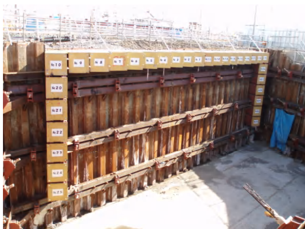
写真-2 箱形ルーフ施工完了状況
