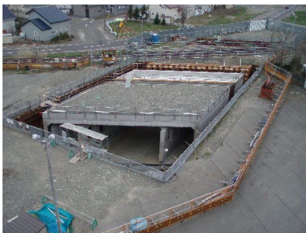
写真-5 函体築造完了状況
