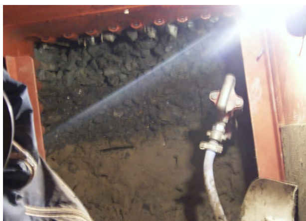
写真-11 刃口内掘削状況
