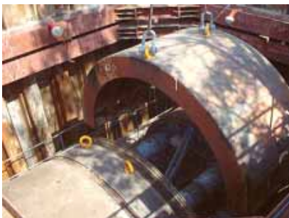
写真-3 前胴上部撤去（到達立坑）
