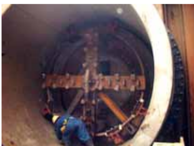
写真-4 掘進機の回収状況（到達立坑より）
