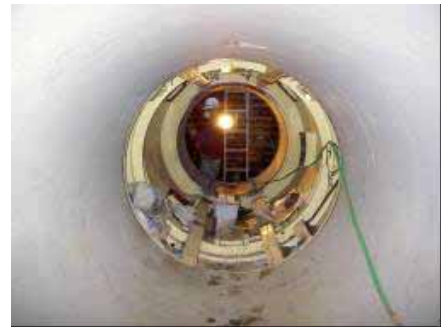
写真-11 外殻・内殻（駆動部）切離し完了
