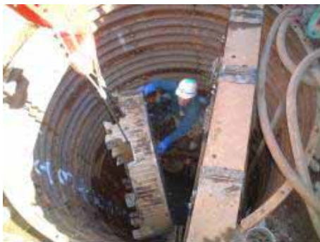
写真-9 面板解体引上げ状況
