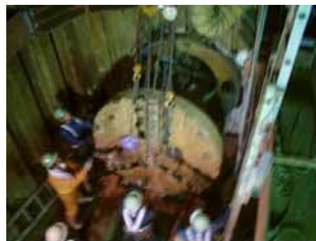
写真-7 シールド機解体状況（機内）
