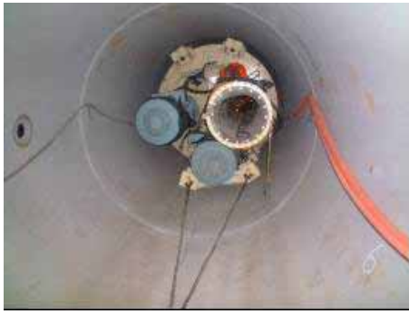
写真-12 駆動部内殻引き戻し状況
