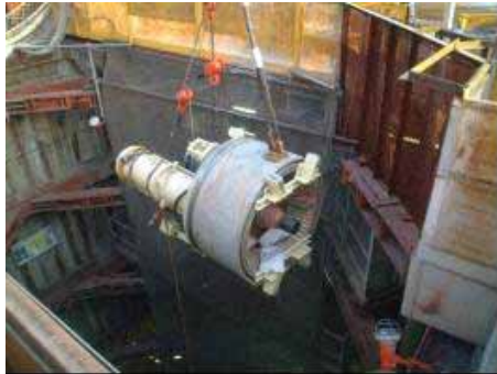
写真-13 駆動部内殻引き上げ状況
