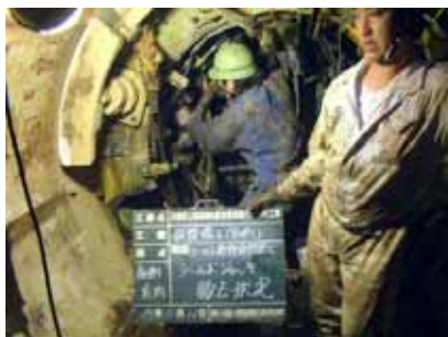
写真-6 シールド機解体状況（機内）
