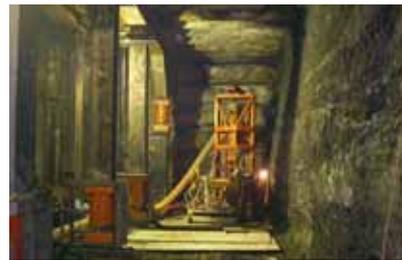
写真-3 仮受杭 (TBH) 杭施工状況
