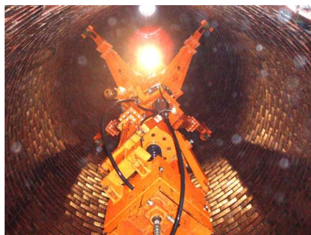
写真-7 レンガ内面除染完了 (煙突下部から上部を望む)
