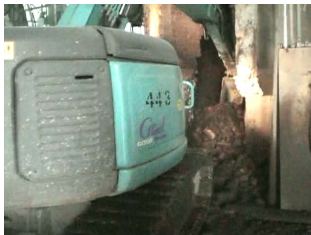
写真-10 バックホウによるレンガの掻き出し
