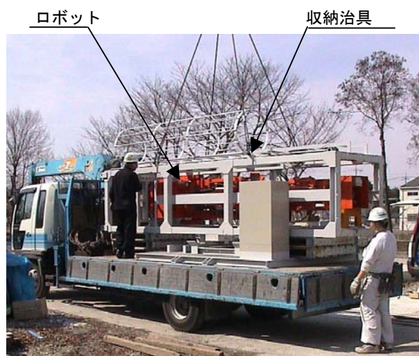
写真-3 ロボットの搬入
