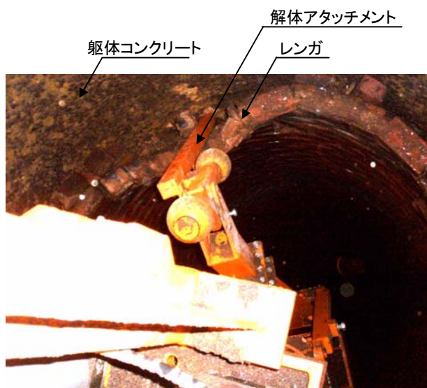
写真-9 レンガ解体状況
