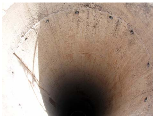
写真-11 躯体コンクリート除染完了
