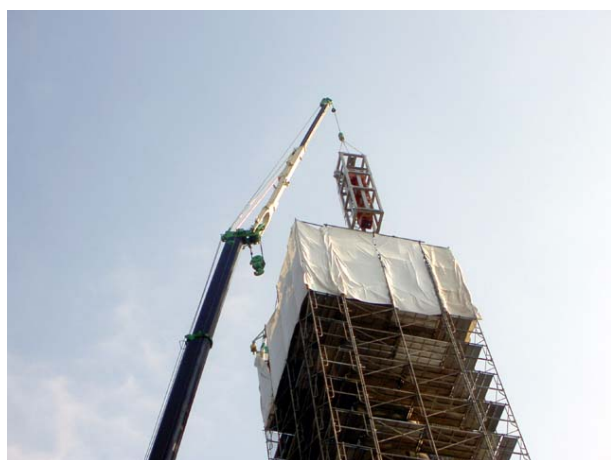
写真-4 ロボットの設置状況
