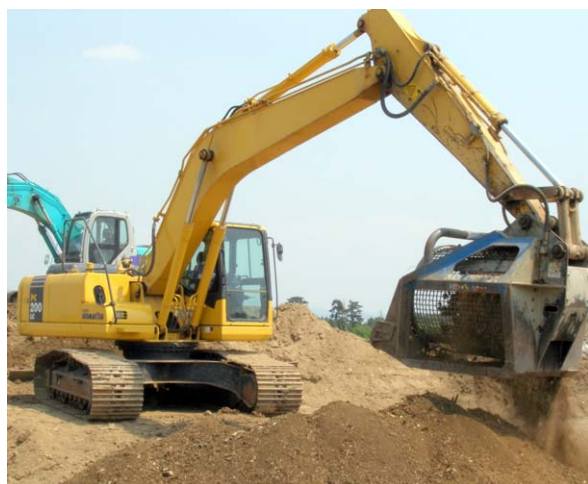
写真-4 ふるい機稼動状況
