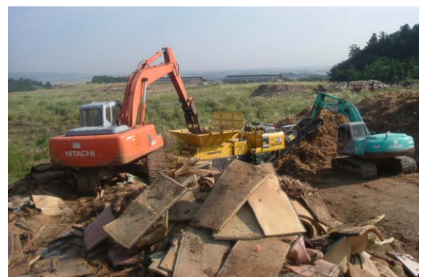
写真- 3 破碎機稼動状況（量）
