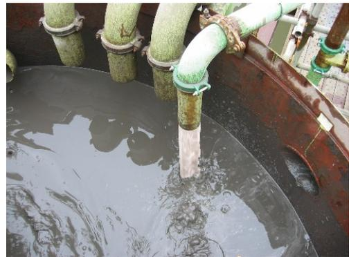
写真-2 Mg系固化材スラリー添加状況
