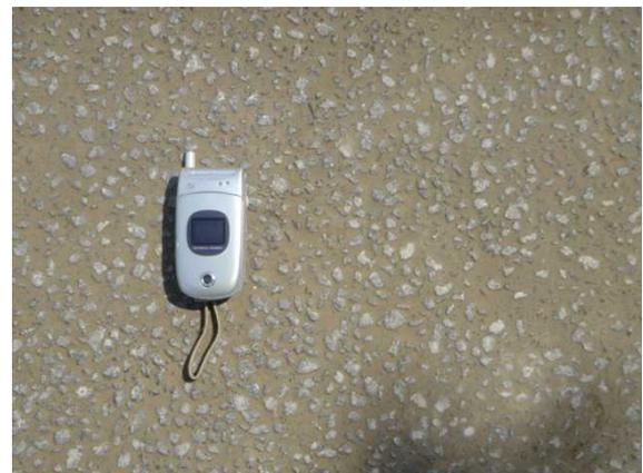
写真-9 保水性舗装表面状況
