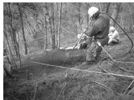
写真-3 エアースコップ施工状況
