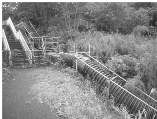
写真-8 仮排水路
