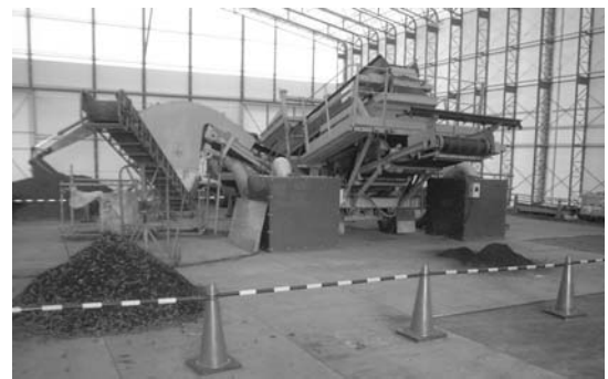
写真-6 地表面回収物の分別分級状況
