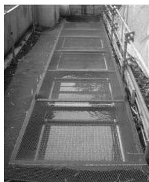
写真-10 排水濾過装置設置状況
