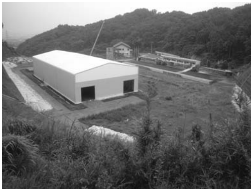
写真-5 分別分級施設（仮設テント）
