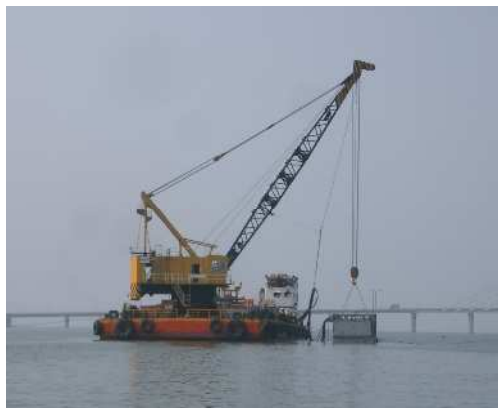
写真-9 スラリーBOX覆砂工法施工状況
