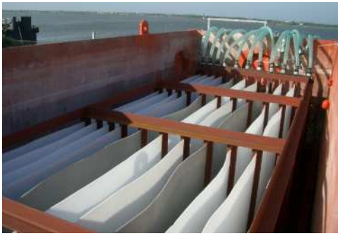
写真-7 クレイフィルタ装置
