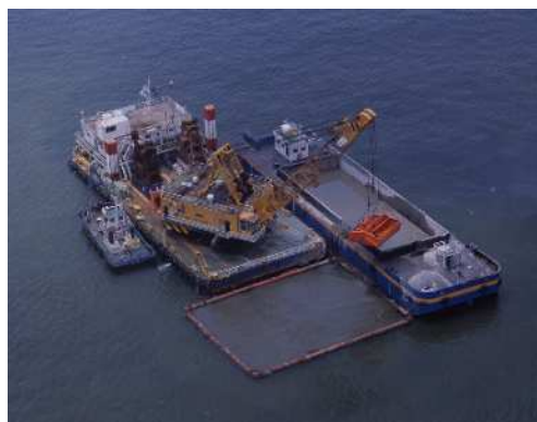
写真-1 END工法施工状況
