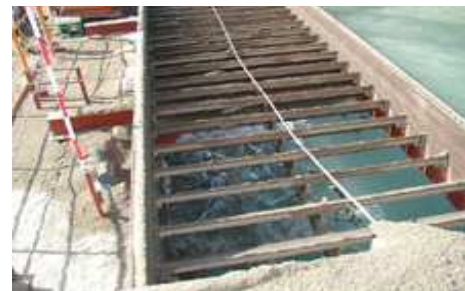
写真-8 ブラインド覆砂装置
