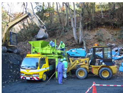
写真-1 甲府管内分別作業状況
