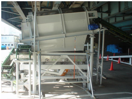
写真-12 分別装置設置状況
