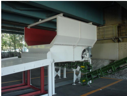
写真-11 塵埃ホッパ設置状況
