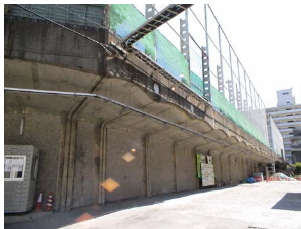
写真-2 亀戸給水所配水池（地上部から撮影）
