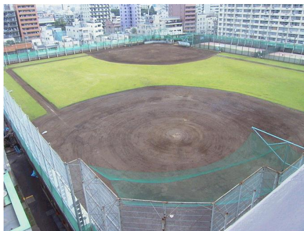
写真-1 亀戸給水所配水池の全景（上部から撮影）
