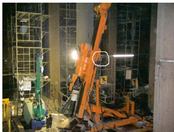
写真-4 角度計の設置状況
