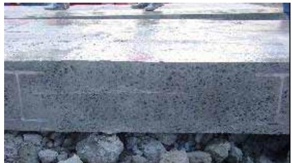
写真-11 支保工まわりコンクリート充填状況
