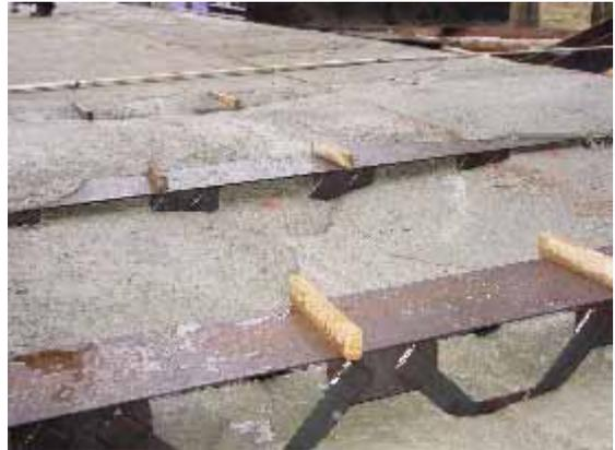
写真-10 コンクリート流動状況
